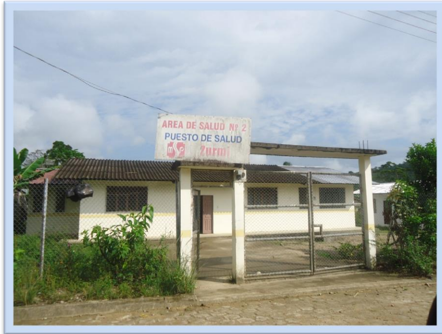
Figura 11. Puesto de salud Zurmi. Vista externa y reconocimiento del puesto de salud Zurmi.
