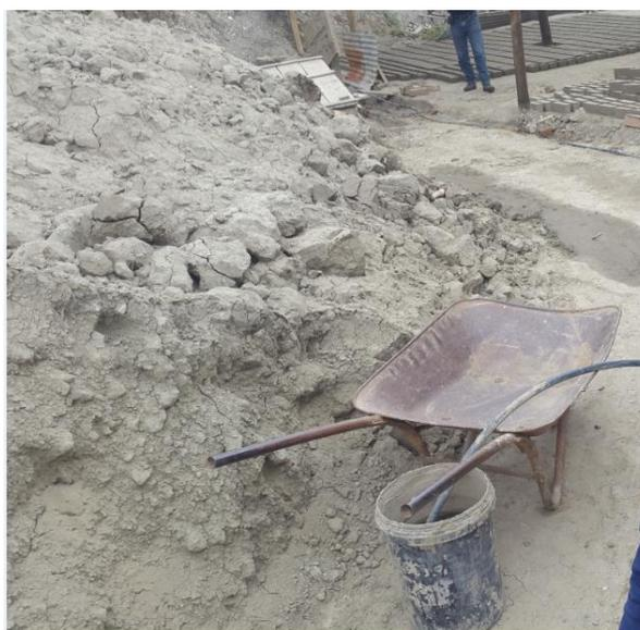
Figura 76. Apilamiento de la materia prima sin previa preparación.
