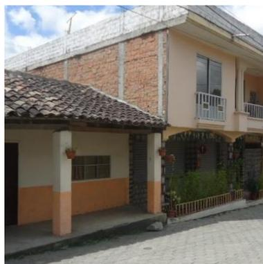
**Ilustración 115.** La vivienda tradicional de Vilcabamba. Sistema Adobe e incorporación de portalerías de Hormigón.
