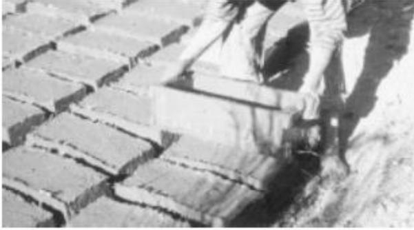
**Ilustración 400.** Proceso de elaboración de adobes en Ecuador.
