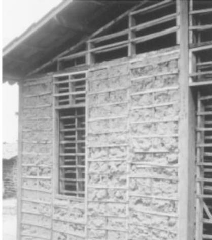
**Ilustración 467.** Bahareque con elementos prefabricados CEPED, Brasil
