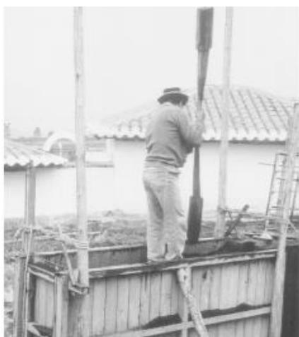
**Ilustración 337.** Pisón de dos cabezas empleado en Ecuador
