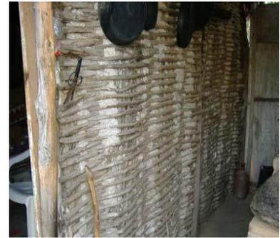
**Figura 3.11:** Estructura de la técnica en bareque
