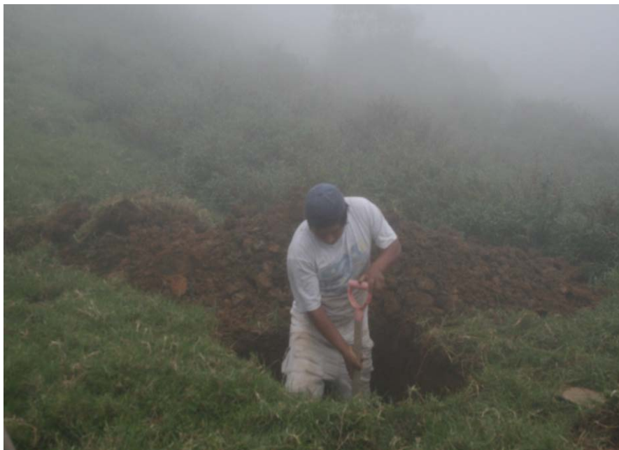
Figura 5.3. Excavación de calicata para muestreo
