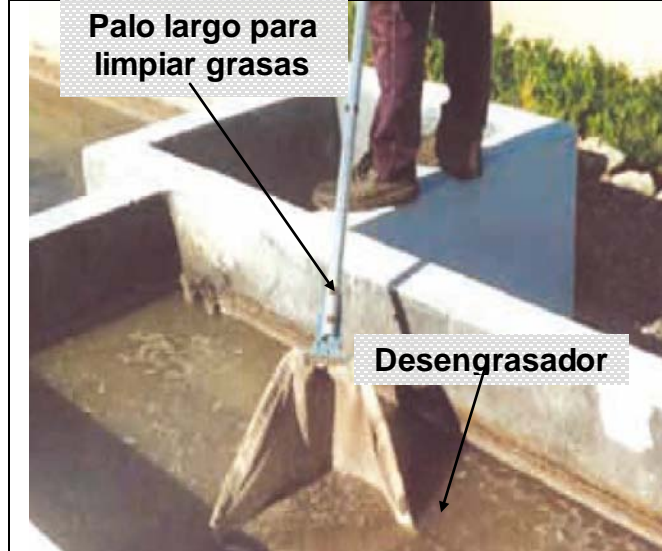
Figura 10.6. Extracción manual de grasas en el desengrasador
