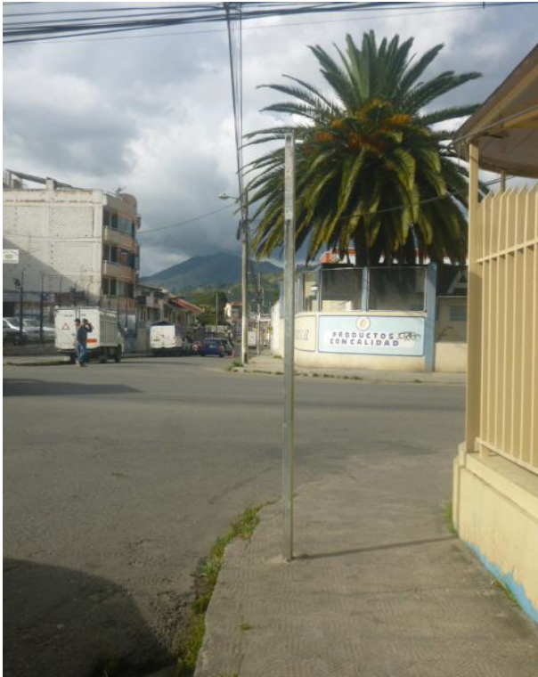
Figura 3.7. Soporte de señal vertical Pare ubicada en las calles Machala y Guayaquil. Fuente y elaboración: El autor
