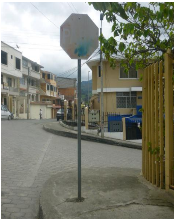
Figura 3.8. Señal vertical ilegible ubicada en las calles Jorge H. Rengel y Eduardo Unda. Fuente y elaboración: El autor
