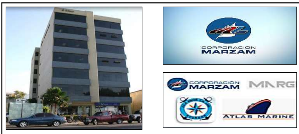
Figura N° 1: Edificación de la Corporación Marzam Cía. Ltda. en la ciudad de Manta.
