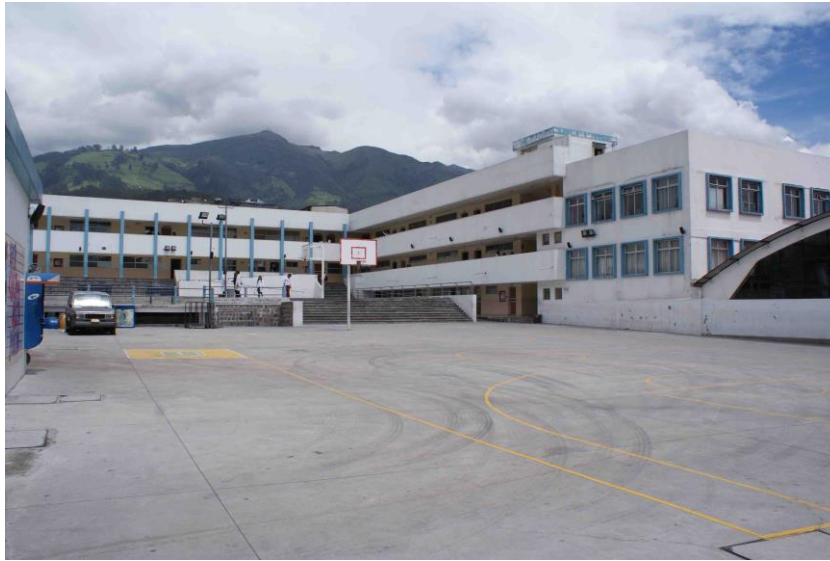
Fotografía No. 3: Patio principal del Colegio Simón Bolívar
