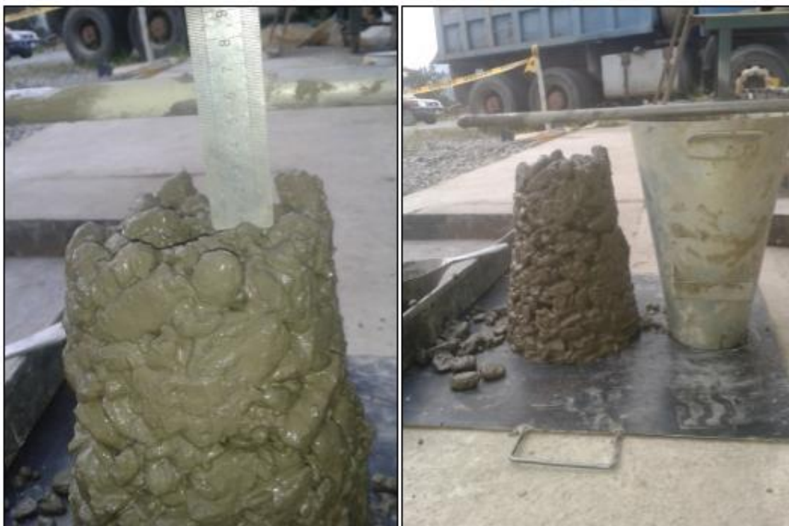
Ilustración 17. Revenimiento o asentamiento (anexo).
