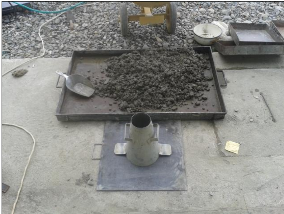
Ilustración 19. Mezcla de material luego de concretera.
