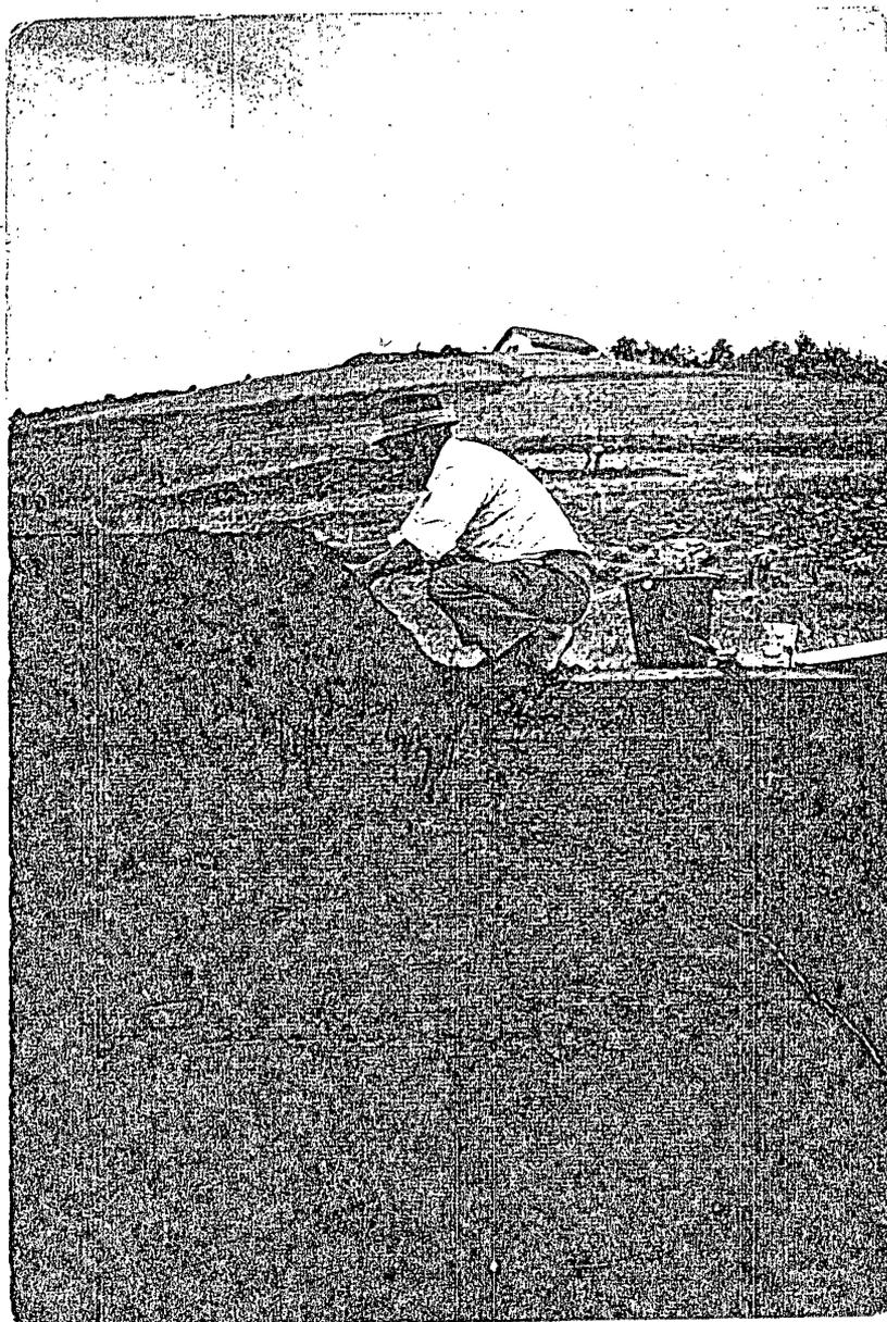
*Construcción del caballete. Consiste en una capa de tierra colocada sobre la pared para protegerla de la lluvia. Se lo fabrica con la misma tierra con que se construyó la pared. En la parte inferior, se puede apreciar la fisura que se origina en el hoyo dejado por el perno pasante.*
