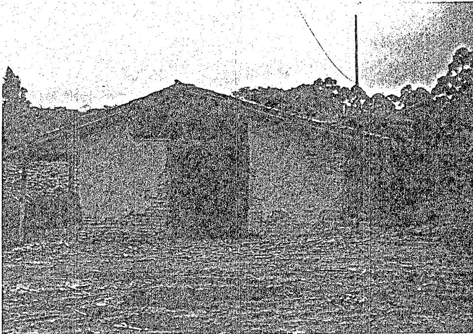
" Malacatos": Construcción en tapial, en la misma que se observa el sobrecimiento, la solera y los pendolones.
