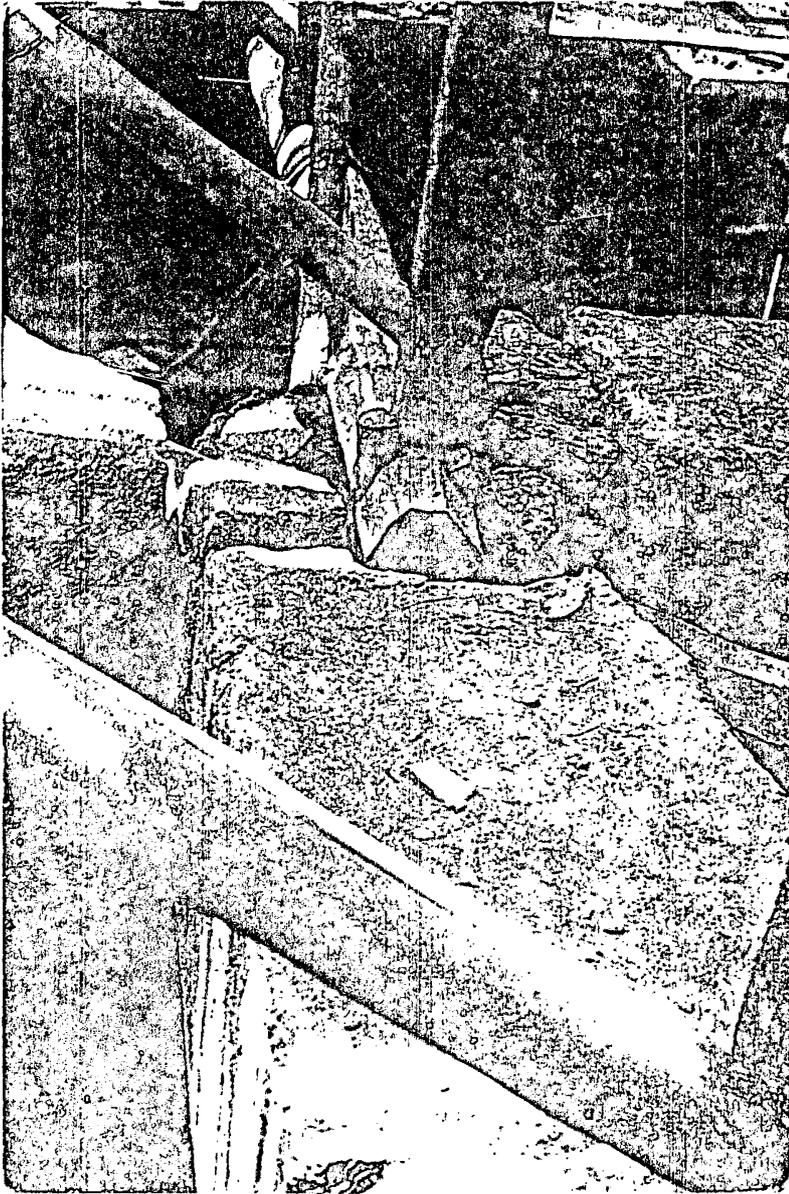
*Pared colapsada. Debido a la no utilización de una solera continua que permita distribuir equitativamente el peso de la cubierta sobre los muros, y a la falta de anclajes de esta con la pared.*
