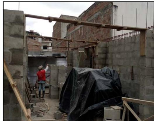
Figura 122: Colocación de Armadura de Viga de amarre sobre Encofrado.
