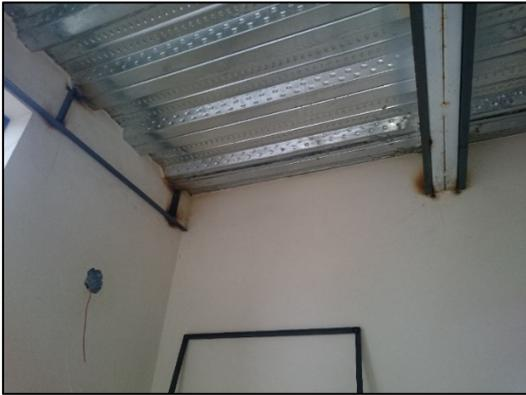
Figura 137: Perfilería metálica para colocación de cielo falso de madera.
