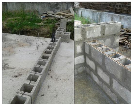
Figura 116: Armado de las Primeras filas de Mampostería Reforzada.
