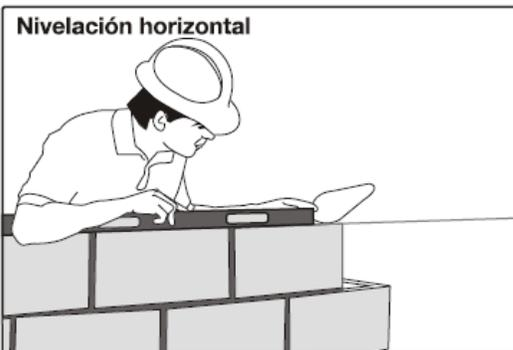
Figura 51: Nivelación horizontal del Bloque.
