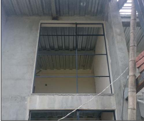
Figura 133: Armado en obra de Perfilera de hierro para ventanas.
