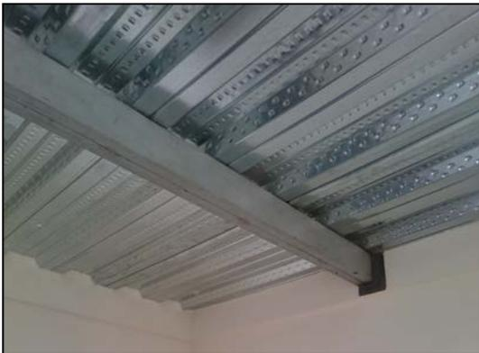
Figura 139: Placa Deck y estructura metálica sin acabado.
