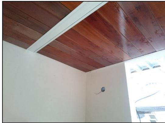
Figura 138: Cielo Falso de Madera y perfilería metálica terminado.
