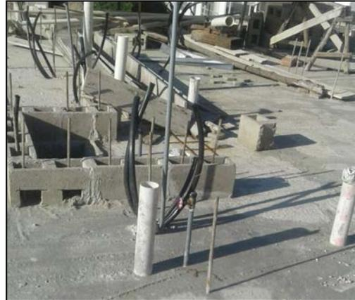
Figura 126: Ducto y esperas de instalaciones sanitarias para el siguiente piso.
