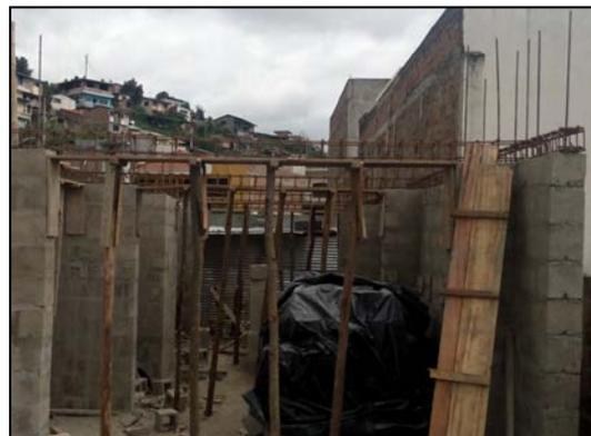
Figura 120: Armado de Encofrado para Vigas de Amarre.
