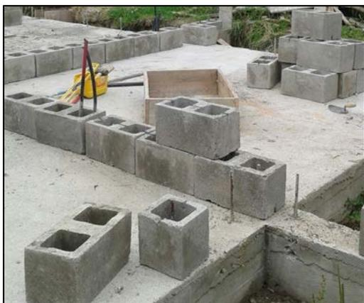
Figura 115: Vigas de Cimentación y Contrapiso.
