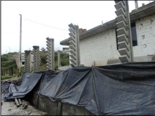
Figura 107: Armado de Columnas de Muro.
