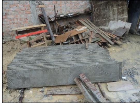
Figura 108: Paneles Prefabricados de Hormigón Armado.
