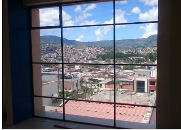
Figura 134: Ventana en perfilera de hierro y vidrio terminada.
