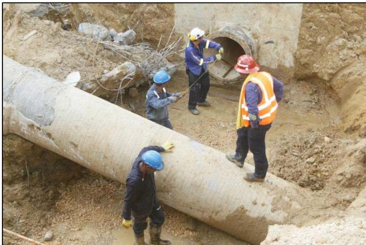
Figura 13. Tuberías de Conducción de aguas residuales urbanas.
