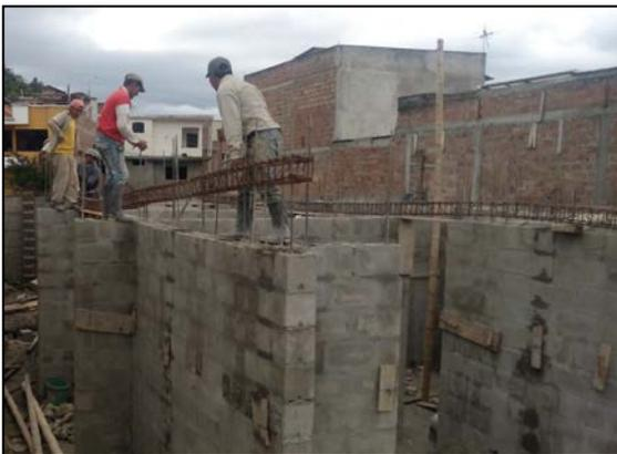
Figura 121: Colocación de Armadura de Viga de amarre sobre Mampostería Reforzada.
