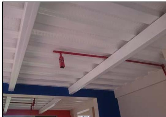
Figura 140: Placa Deck y estructura metálica pintada con Pintura Anticorrosiva.
