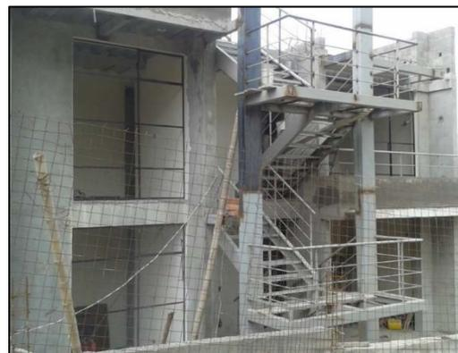
Figura 128: Armado de Grada en Acero Estructural y perfilera metálica.
