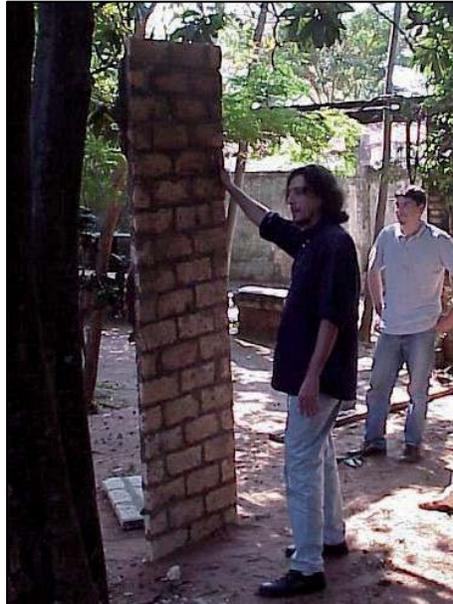
Figura 65: Gabinete de Arquitectura, Panel Cerámico Prefabricado de Canto.
