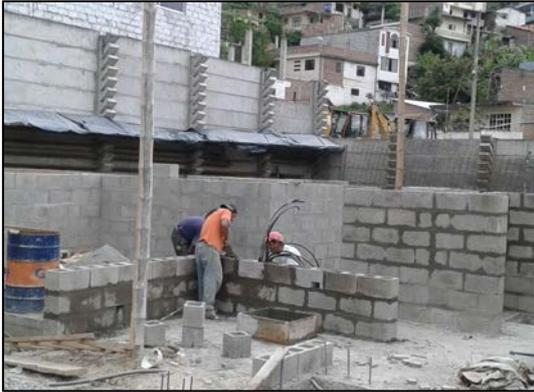
Figura 117: Armado de esperas de Tubería para Instalación Eléctrica.
