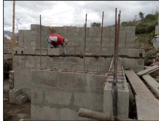
Figura 118: Armado de Refuerzo Horizontal en Mampostería Reforzada.
