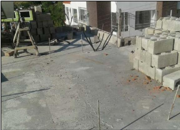
Figura 125: Novalosa terminada y con esperas de Hierro e instalaciones para el siguiente piso.
