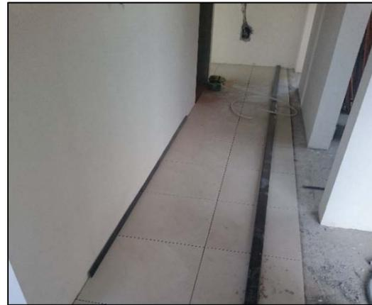
Figura 130: Revestimiento de paredes y colocación de Porcelanato en pisos.
