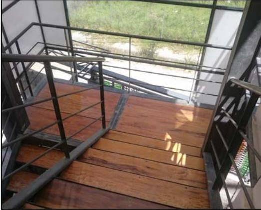
Figura 129: Grada en perfilera metálica con escalones de tablón de madera.
