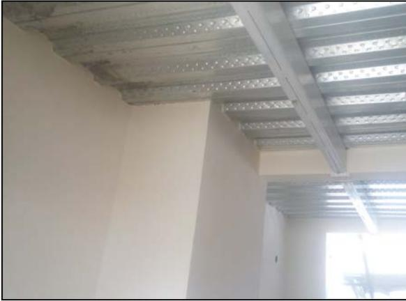
Figura 123: Armado de Vigas Metálicas para soporte de Placas Deck.
