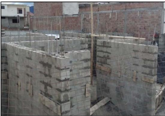
Figura 119: Mampostería Reforzada lista para armar las Vigas de amarre.
