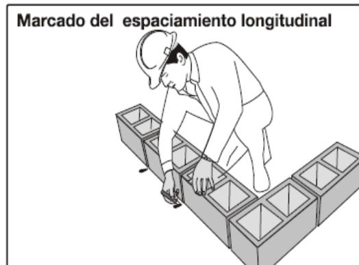
Figura 43: Colocado de bloque según la separación longitudinal deseada.
