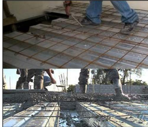
Figura 124: Armado de malla y fundición de Novalosa.
