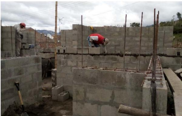
Figura 35: Detalle de refuerzo vertical dentro de los Bloques vibro comprimidos.
