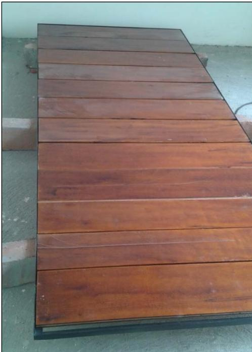
Figura 135: Armado en obra de puerta de madera con perfilera de hierro.
