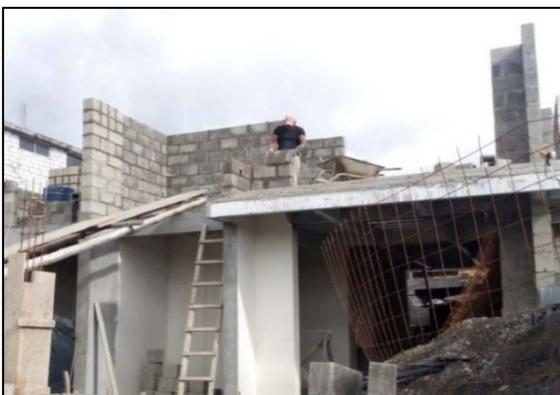
Figura 127: Armado de Mampostería Reforzada en Primera Planta Alta.
