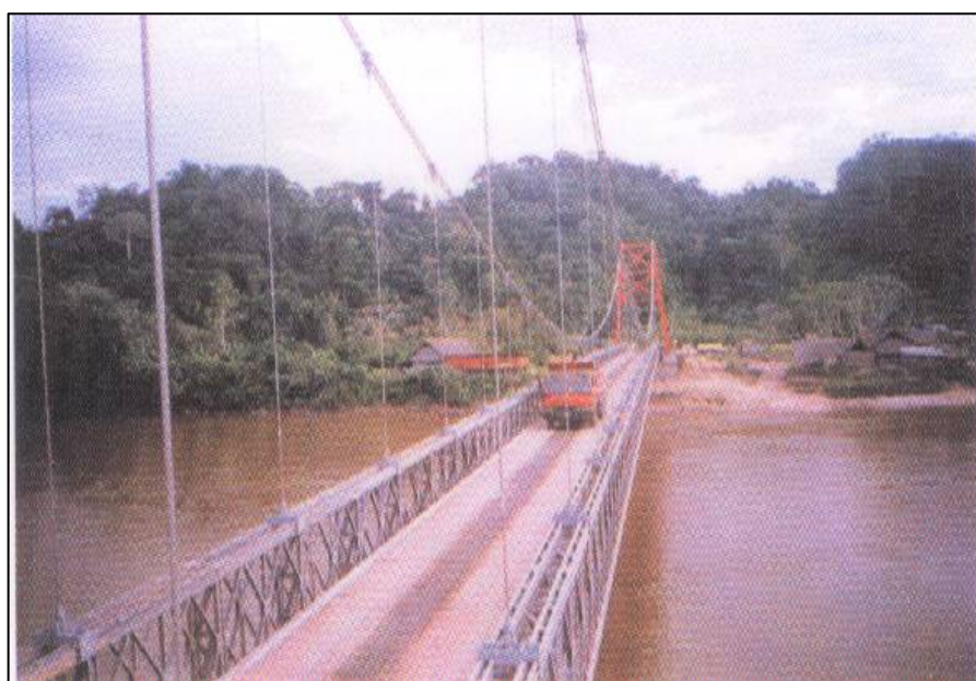
Figura N° 3. Puente sobre el río Nieva, Eje Vial no. 4 Fuente: Plan Binacional Capítulo Ecuador, 2007
