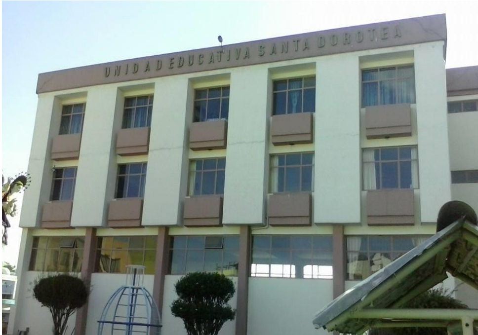
Ilustración 6. Fachada principal de la Unidad Educativa Giovanni "Santa Dorotea" en el Cantón Quito provincia de Pichincha.
