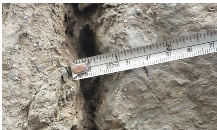
Foto 8. Medición de aberturas.
