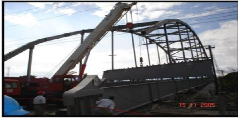
Figura 16. Proceso de montaje Fuente: Santa Bárbara, 2013 Elaborado por: Garcés, Patricia
