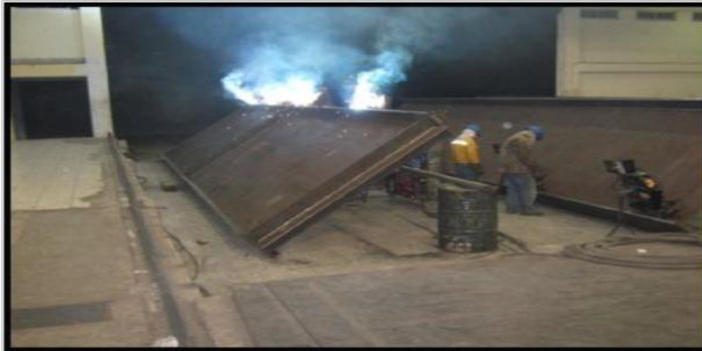
Figura 15. Proceso de soldadura Fuente: Santa Bárbara Elaborado por: Garcés, Patricia
