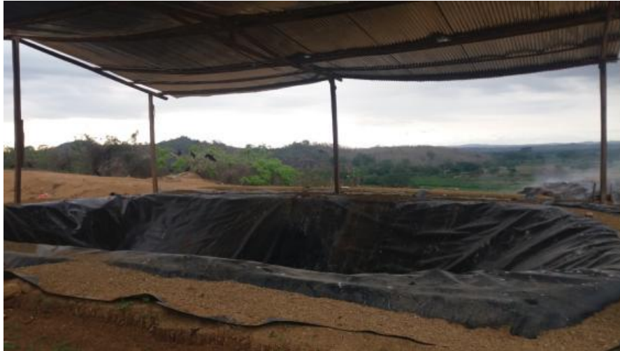
Foto No. 20. Celda emergente para residuos hospitalarios.
