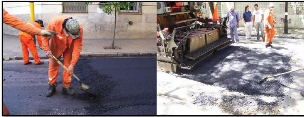
Figura 8: Colocación en Argentina de mezcla asfáltica tibia
