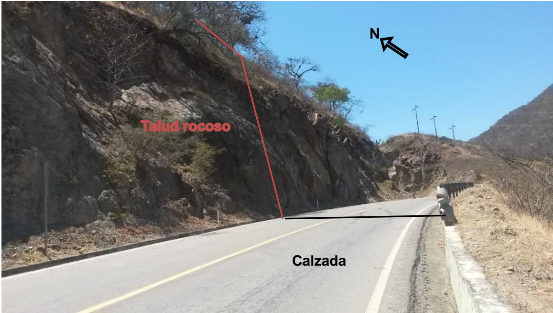
Figura 4. Vista de la carretera sector Lucarqui, con dirección al NE, hacia Loja, donde se aprecia la calzada de carretera y talud rocoso.
