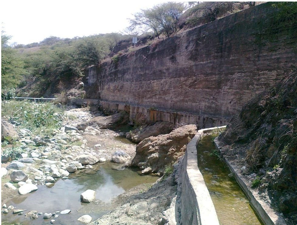
Imágenes del Canal Puente-Playas, Paltas.
