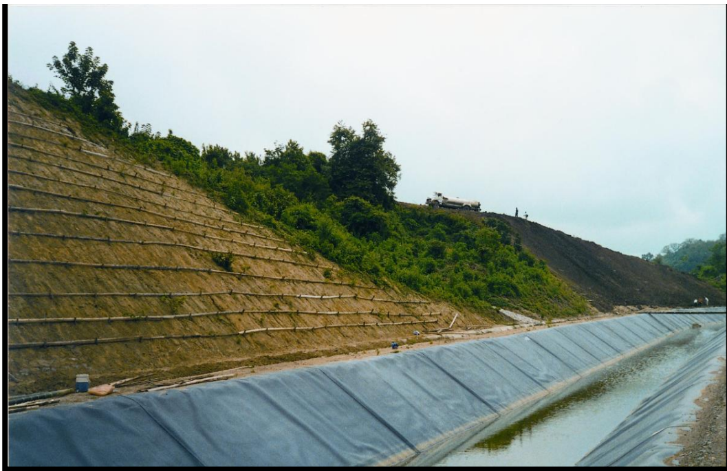
Fig. 2.1: Vista de un talud
