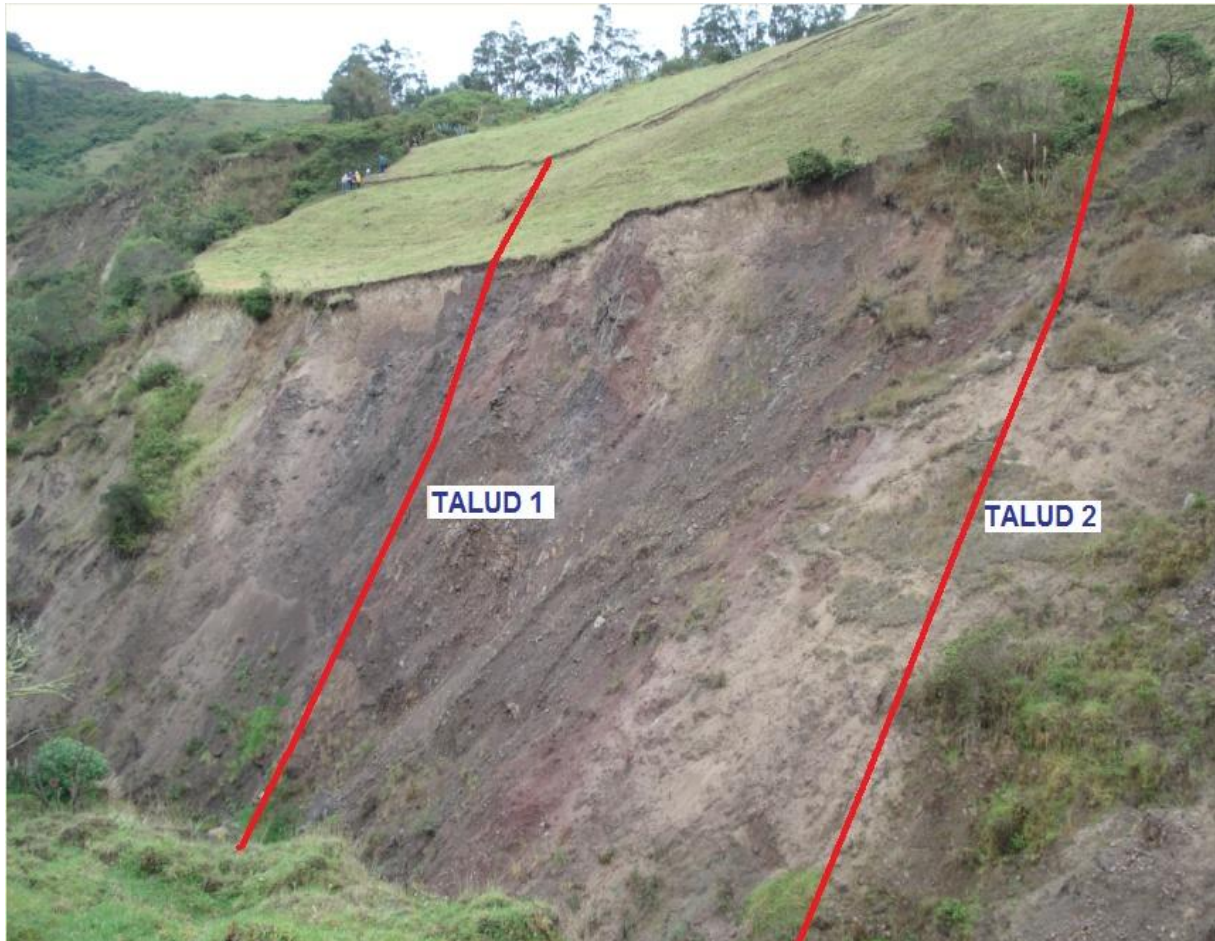
Figura A.1.3: Vista frontal del talud 1 y talud 2
