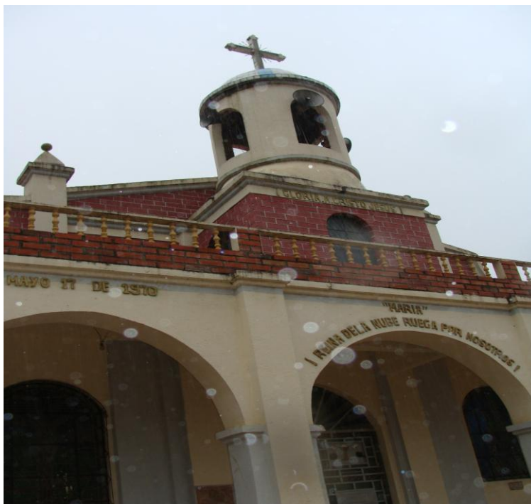
Foto No. 6 Parte frontal de la Iglesia de Sigcho de la Parroquia de Sinincay Alto
