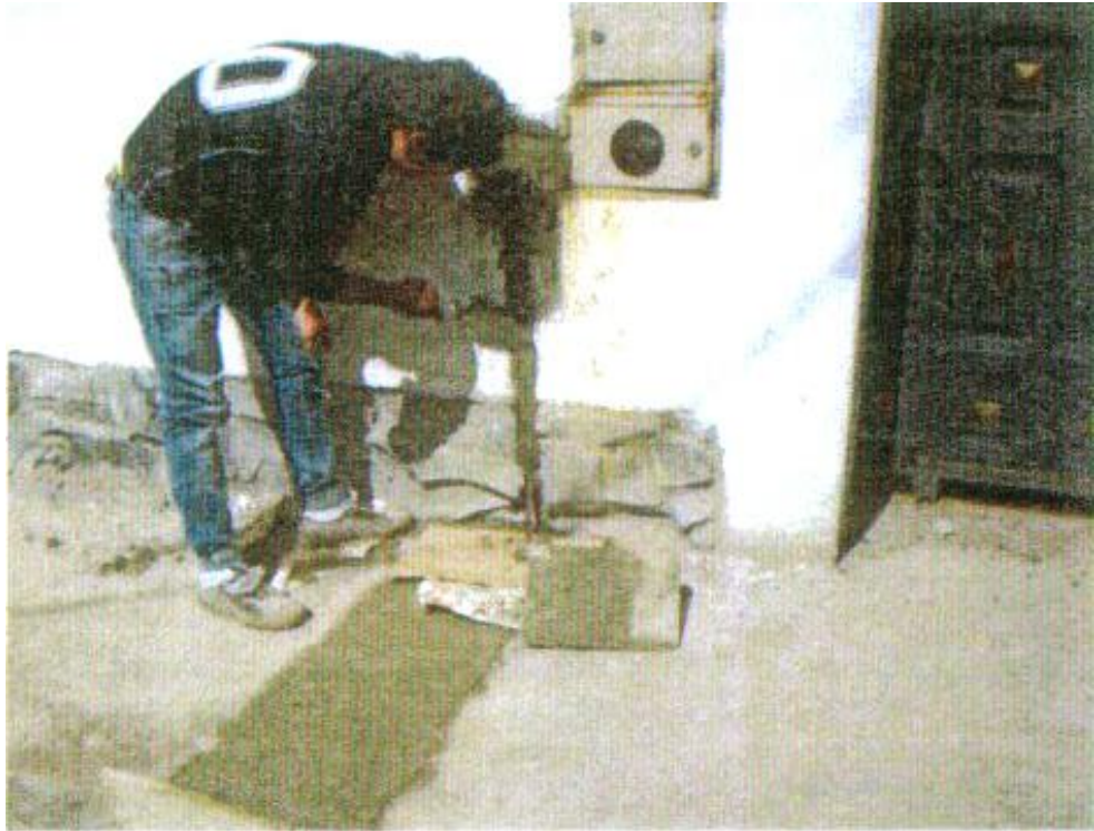
Foto No. 3 Trabajadores realizando instalaciones domiciliarias para el suministro de agua no tratada.
