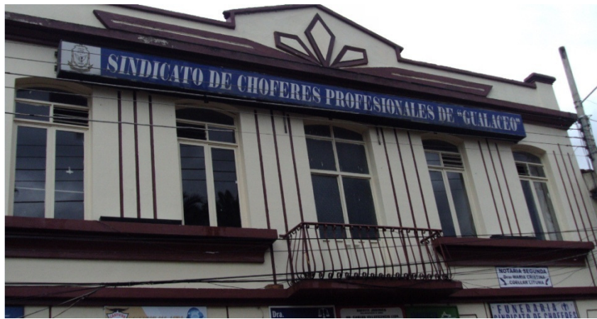
Fotografía N. 1: Edificio del Sindicato de Choferes Profesionales del Cantón Gualaceo
