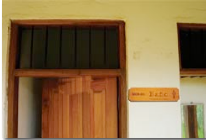
Fig. 20. Colocación de letreros en la UCB-Ch Autor: Diego Ganazhapa
