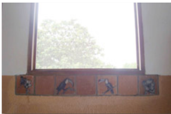
Fig. 25. Colocación de las baldosas sobre la pared Autor: Diego Ganazhapa
