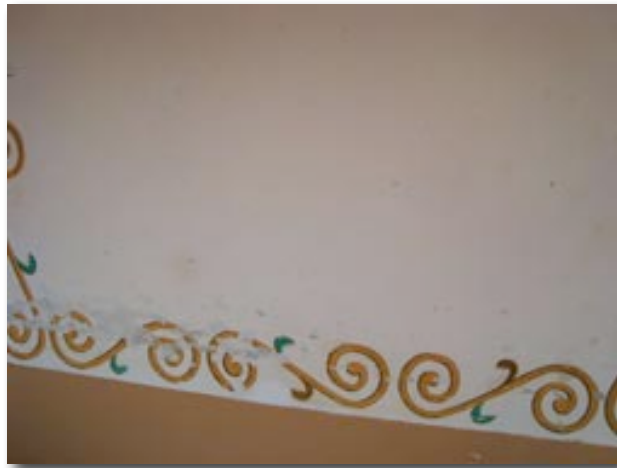
Fig. 22. Facha antigua - exterior Albergue Fotografía: Diego Ganazhapa
