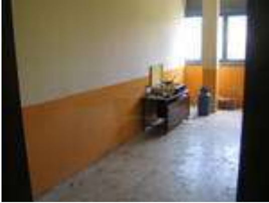
Precaria cocina de la planta
