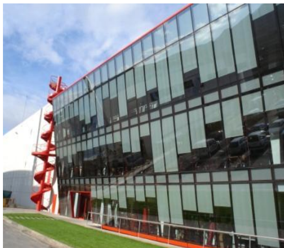
Fig. 2.6. Uso de películas solares sobre los ventanales de un edificio.
