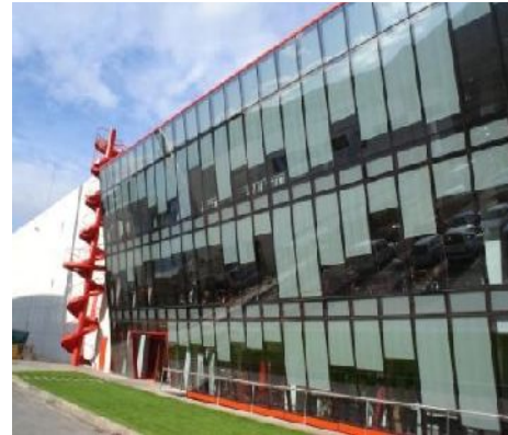
Fig. 6. Uso de películas solares sobre los ventanales de un edificio.
