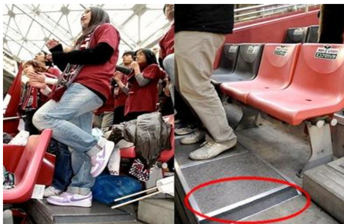
Fig. 2.7. Baldosas piezoeléctricas en el Misake park stadium. Kobe. Japón
