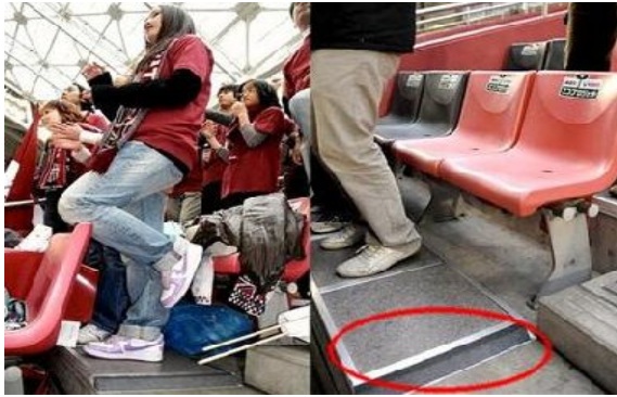
Fig. 7. Baldosas piezoeléctricas en el Misakeparkstadium. Kobe. Japón
