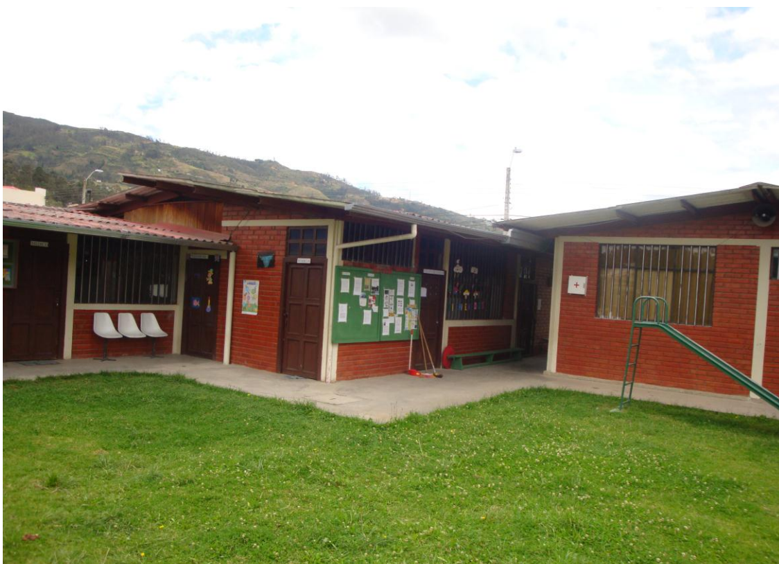
Foto N° 3 Vista de interior del local de Instituto de Educación Especial de Gualaceo
