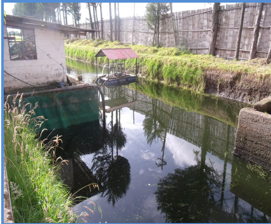
Fotografía N° 9: Reservorio de Zapad Vostok
