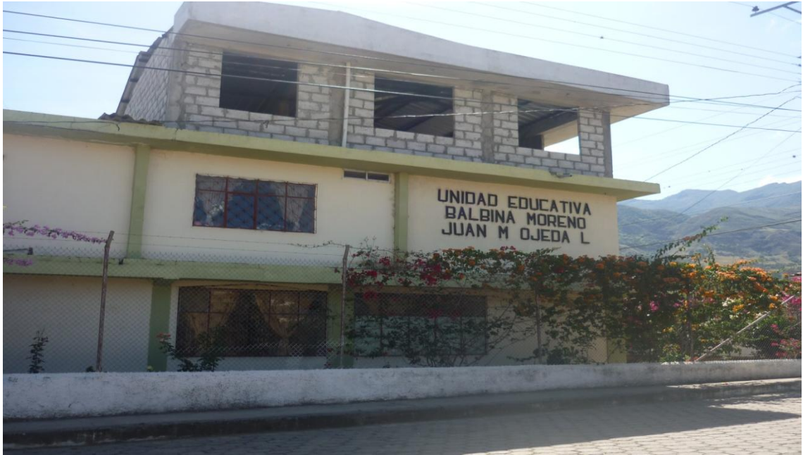
Fotografía 1: Vista frontal del edificio donde funciona la Unidad Educativa Balbina Moreno – Juan Manuel Ojeda Luna.
