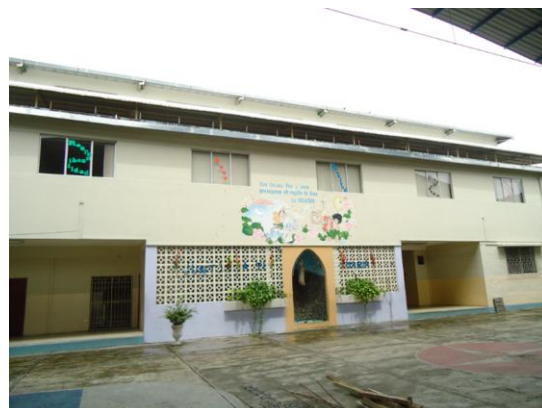
Foto 6. Bloque de aulas
