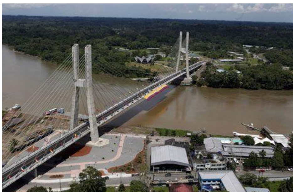
Vista panorámica del puente sobre el río Napo. Presidencia
