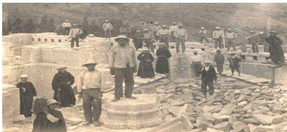
Obreros, franciscanos y vecinos durante la construcción del templo de San Francisco.
