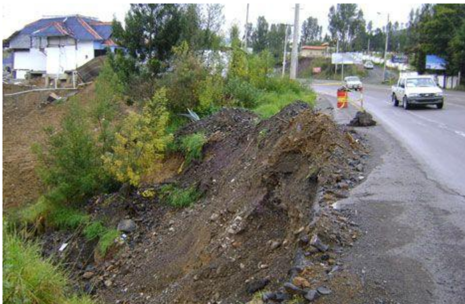
En el sector de Pampavintimilla un tramo de la carretera prácticamente ha desaparecido por los deslizamientos. EL TIEMPO
