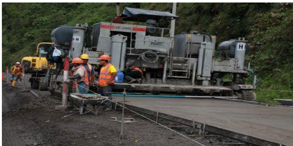
Trabajadores de la empresa Hidalgo & Hidalgo, encargada de la obra, colocan el hormigón en el sector La Delicia. Diego Cáceres | EL TIEMPO
