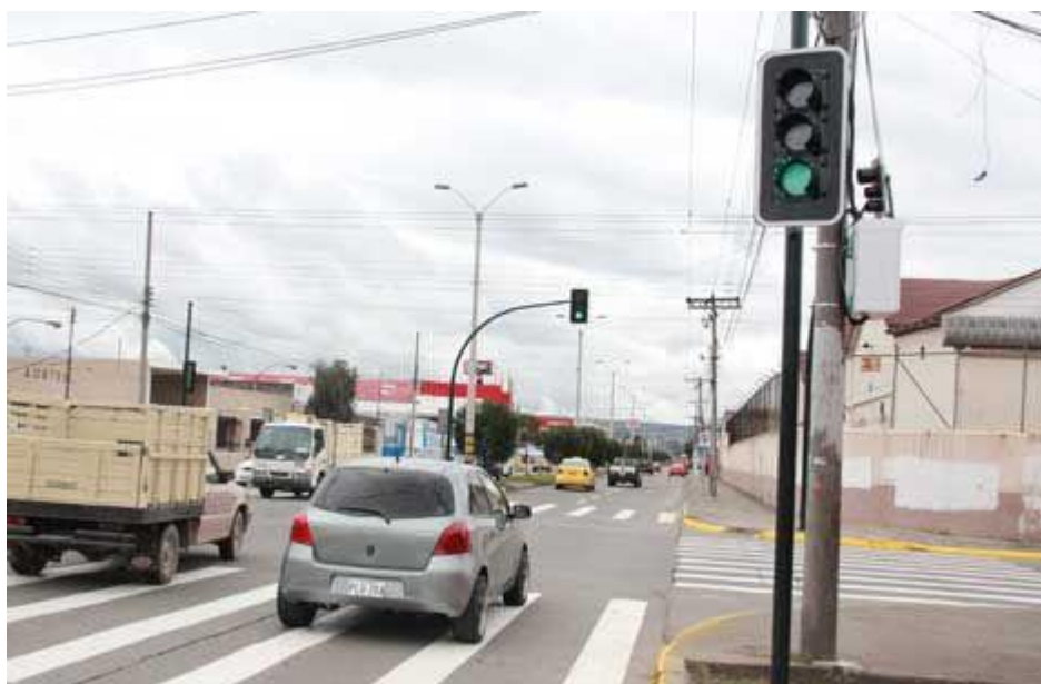
Semáforos reparados en la avenida Gil Ramírez Dávalos.
