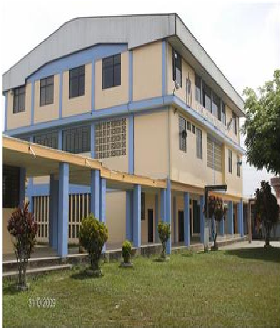
Parte de la infraestructura del colegio Pio XII. Año 2009 Fuente: Lcda. Gardenia Vélez
