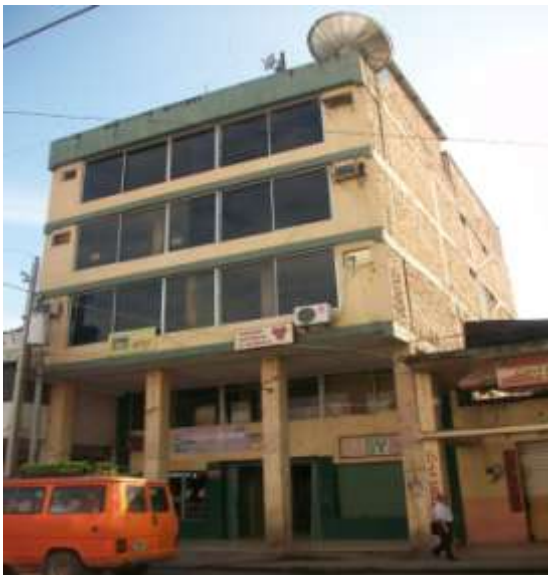
Foto #10: Edificio Giler Calles Pedro Gual y García Moreno, séptimo establecimiento del centro.
