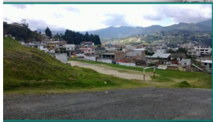
EQUIPAMIENTO DE SEGURIDAD
