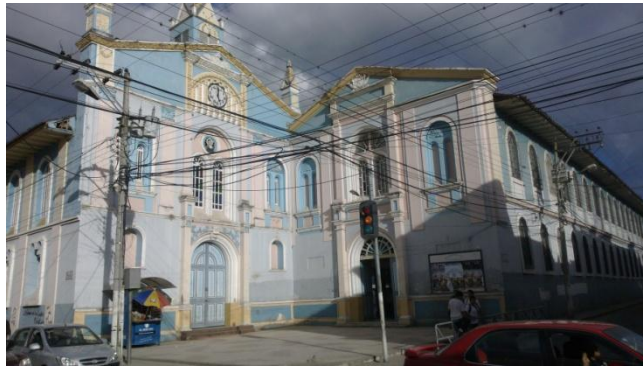
Foto 3.4.- Contaminación visual – cableado. Fotografía: Tomada por la autora, Mayo 2012.
