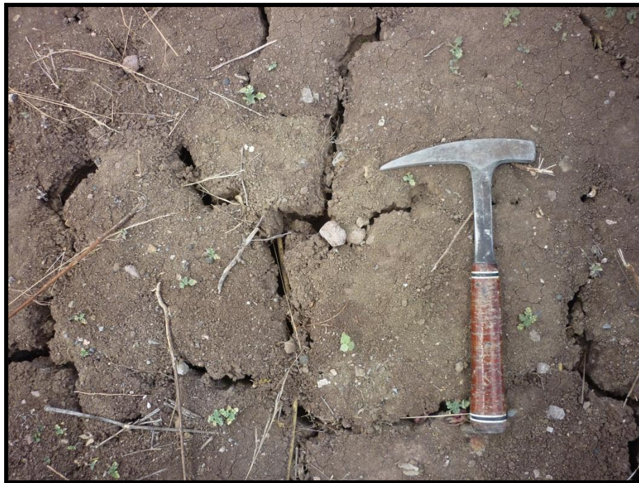
Foto Nro. 17. Arcillas expansivas con alto contenido de montmorillonita. Sector, Barrio “Trapichillo”.
