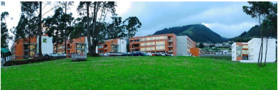
VISTA EXTERIOR DEL CAMPUS OCCIDENTAL UTE
