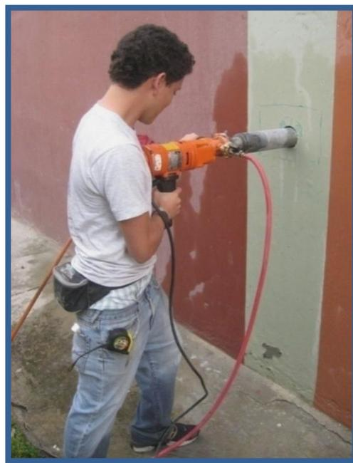
**Figura 4-3** Extracción de núcleos de hormigón en columna - CITTES
