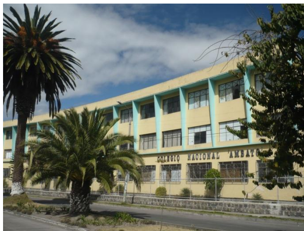
Vista Principal del Edificio
