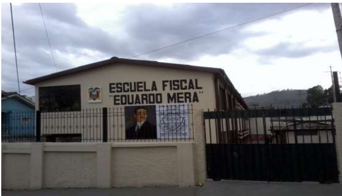
Fachada principal de la Escuela Fiscal "Eduardo Mera".
