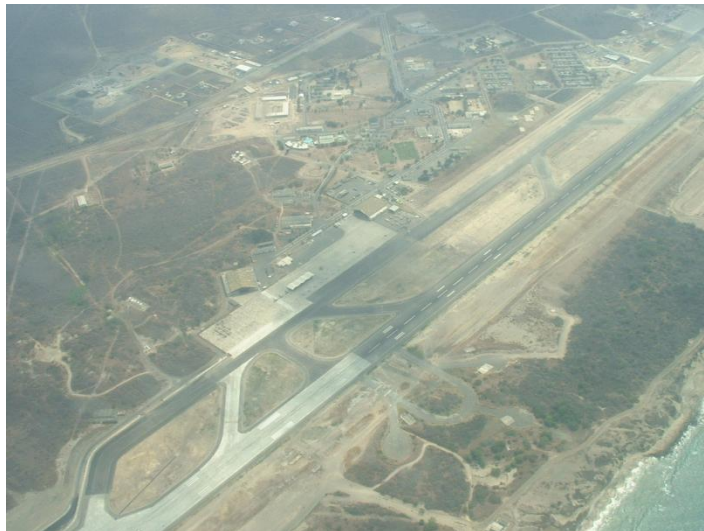
FOTOGRAFIA 1.8 AEROPUERTO ELOY ALFARO
