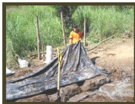
Foto ? 4.- Geomembrana utilizada en la perforación para prevenir las infiltraciones de combustibles y grasas utilizadas en el proceso
