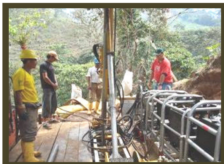
Foto ? 5.- Perforadora con los técnicos durante el proceso de extracción de testigos
