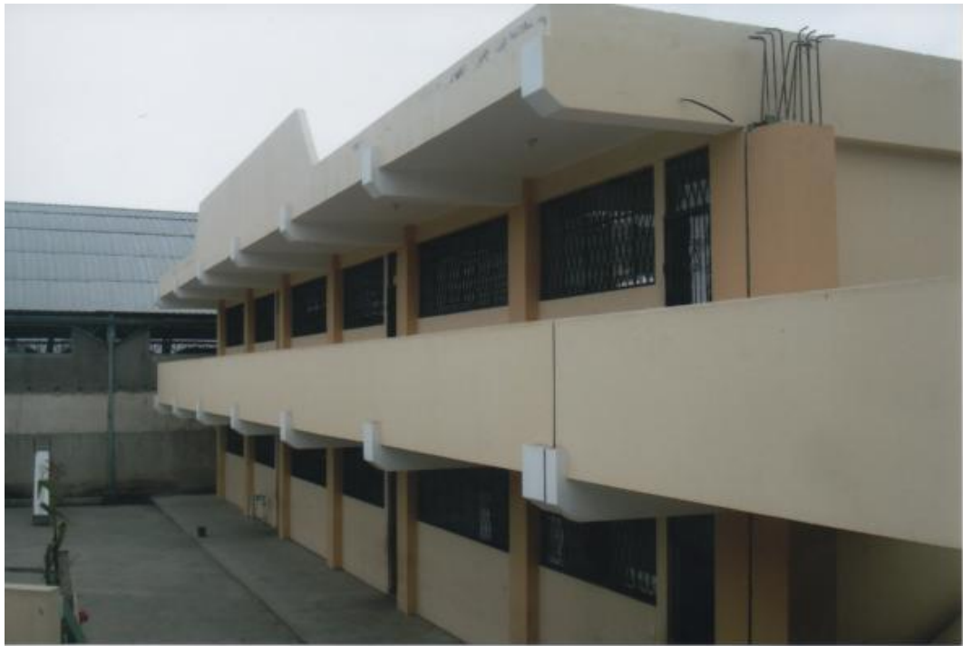
Nueva infraestructura con que hoy goza la Institución.
