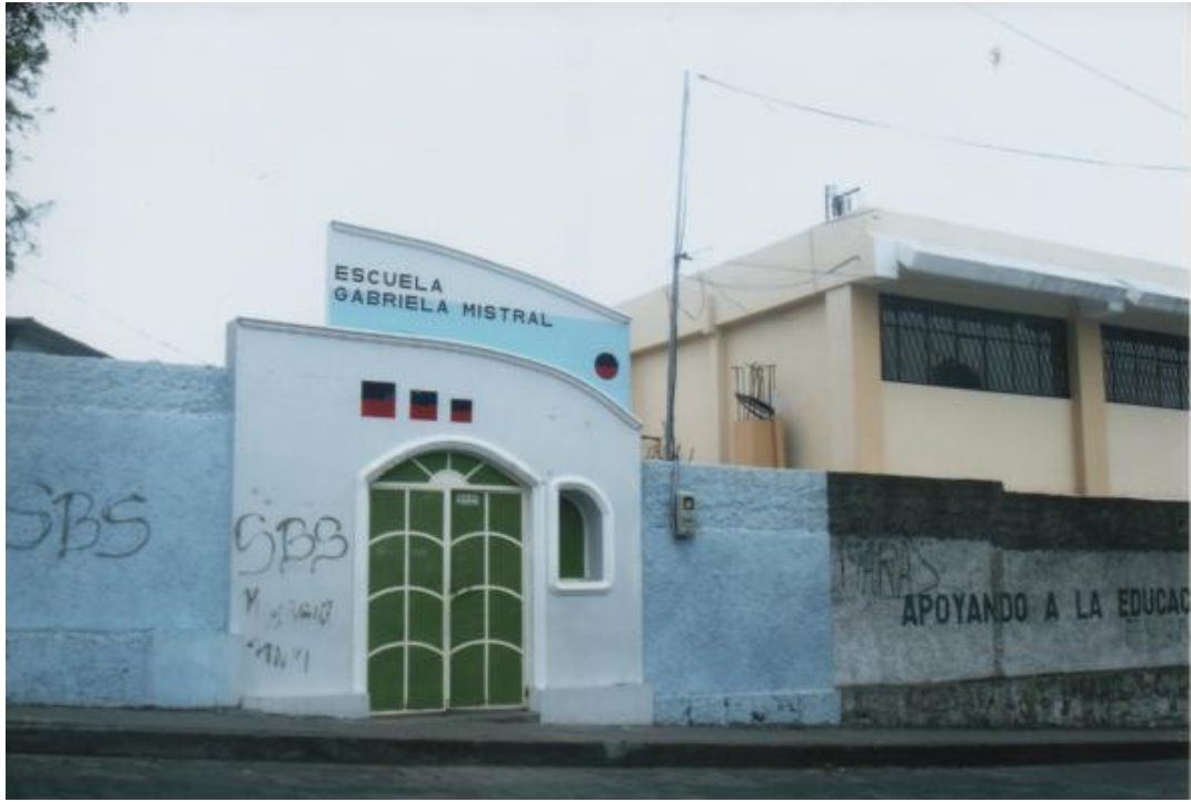
Entrada principal de la Institución
