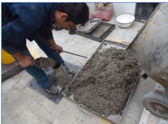
Figura 3-6 Hormigón en estado fresco.
