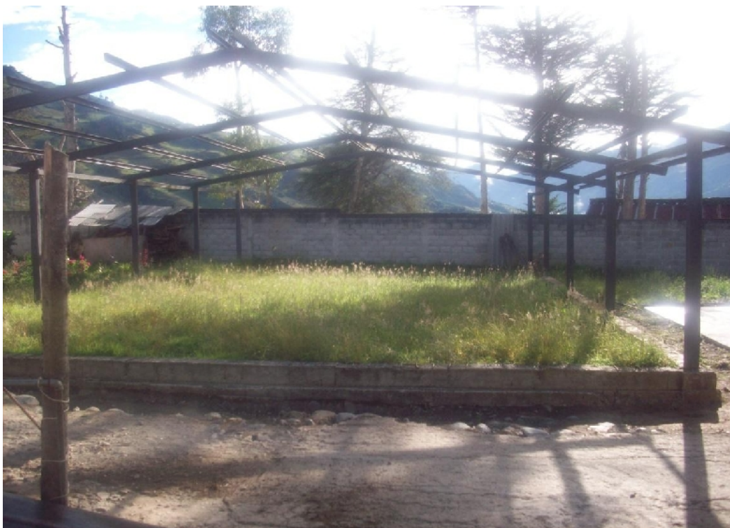
(Fig. 9) Salón de uso múltiple en construcción.
