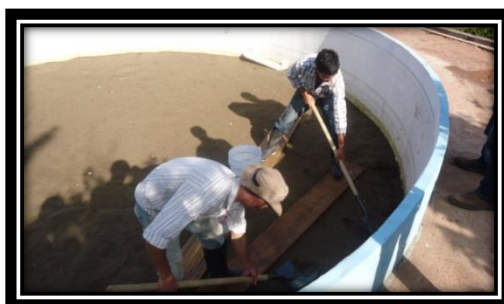
Imagen 6.4 Raspado de filtros
