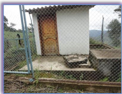
Imagen 1.5 Tanque de almacenamiento
