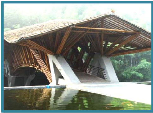
Figura 8. Puente elaborado con guadua.
