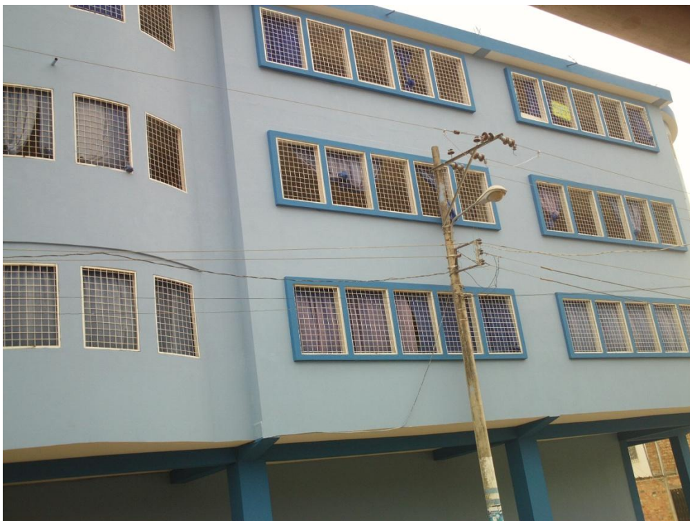
Pabellón construido en el año 2010.
