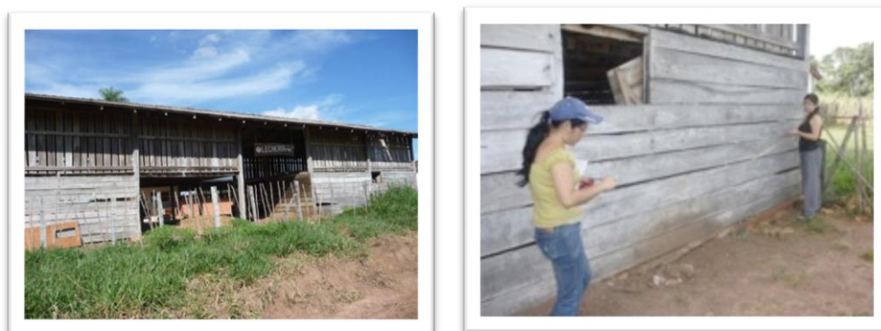
Ilustración 24. Estado actual de la lechería
