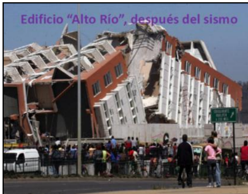
Figura 1.60 Falla en la cimentación, sismo Chile, 27/02/2010 Fuente: [Fernández Cruz, O. (2010)]
