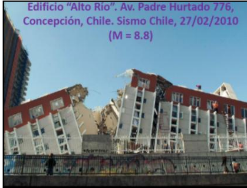
Figura 1.59 Volteo de un edificio por falla en la cimentación, sismo Chile, 27/02/2010 Fuente: [Fernández Cruz, O. (2010)]
