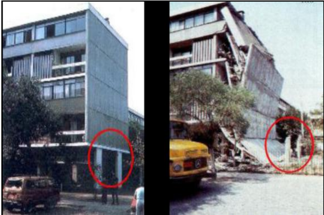
Figura 1.10 Colapso por discontinuidad de elementos estructurales verticales
