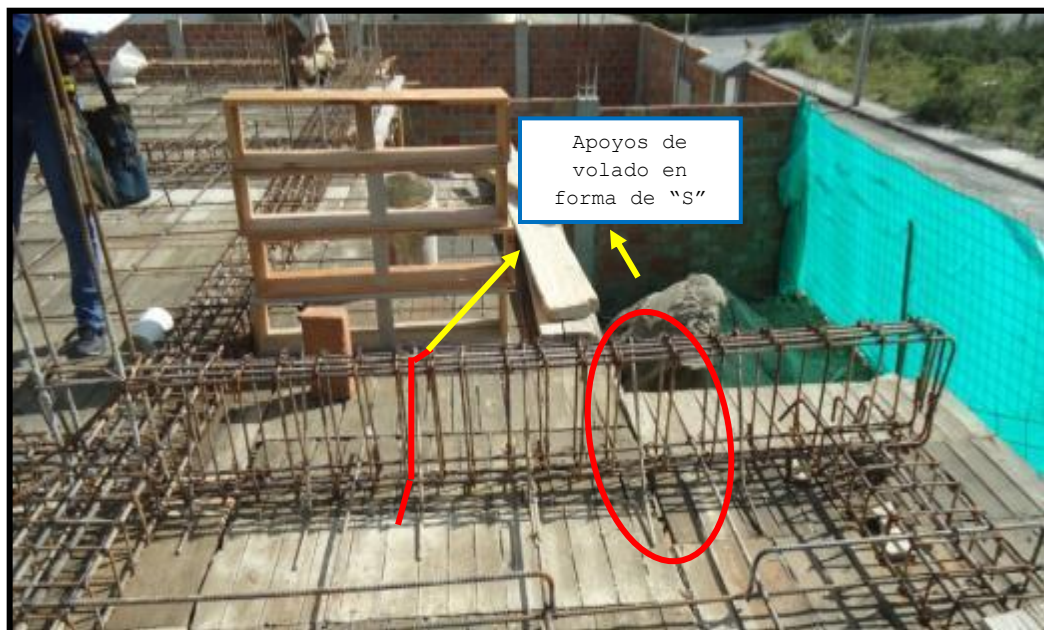
Fot.3.57 Viga de volado, con varillas en forma de S en toda su longitud
