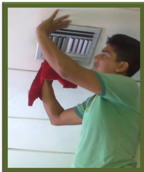
Foto: Limpieza de ductos de Aires
