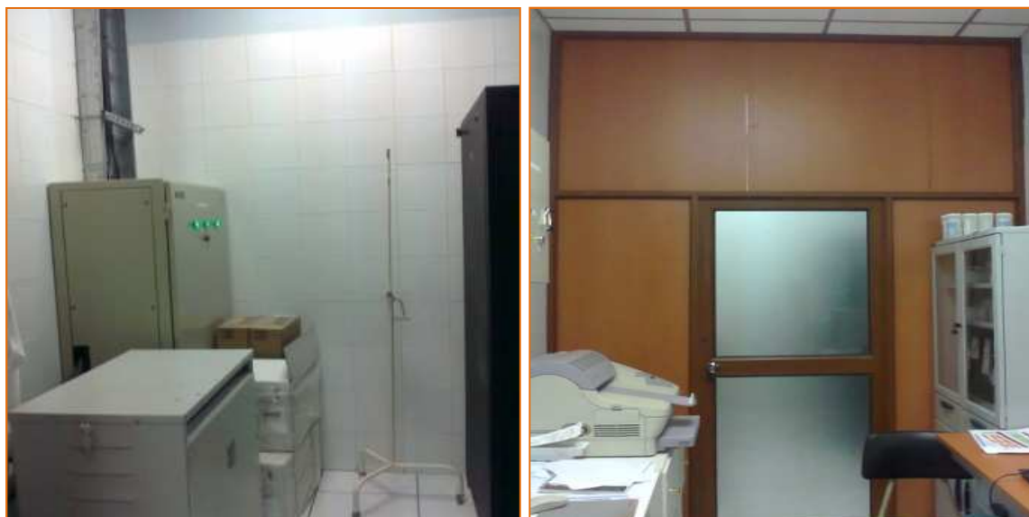
Foto: instalación de mampara de separación de ambiente de TAC
