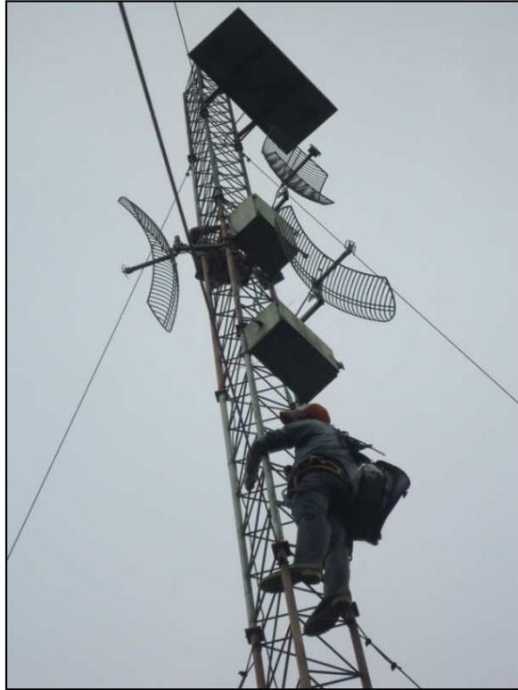
Fig. 2.15 Sustitución enlace a 2,4GHz por 5,8GHz – repetidor 2. Elaborado por los autores.
